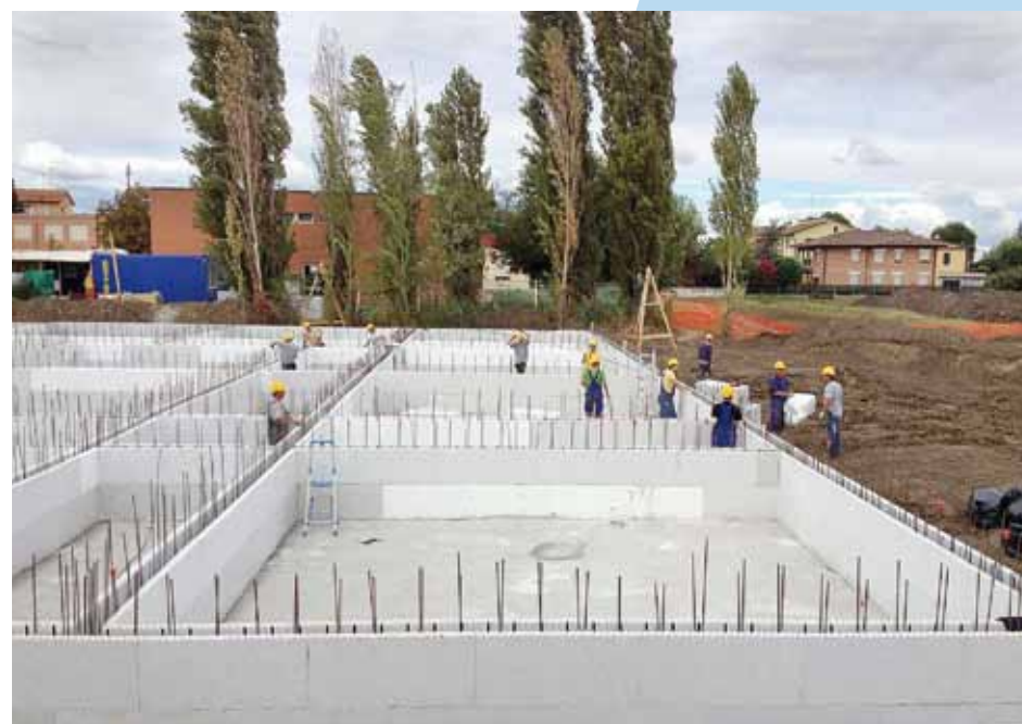
INSERIMENTO ARMATURE
